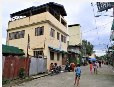
中継の拠点となったパヤタスクエア センター（アイキヤン所有ビル）
